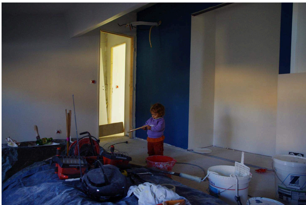
Emmanuelle et François, Rénovation de maison, Vaucluse, 2012 © saisirlechancier DR
