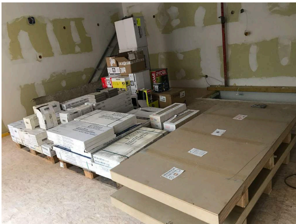
Emmanuelle et Julien, Rénovation de maison / livraison de carrelage, Strasbourg, 2018 © saisirlechantier DR
