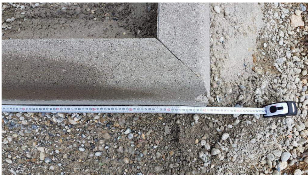
Maître d'œuvre, Rénovation de maison, Alsace, 2017-2018 © saisirlechantier DR
