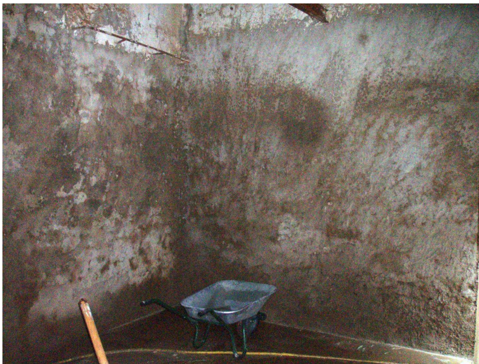
Emmanuelle et François, Rénovation de maison / "no man's land", Vaucluse, 2010-2012 © saisirlechancier DR
