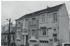
Rue de la Parmentière, immeuble années 40
