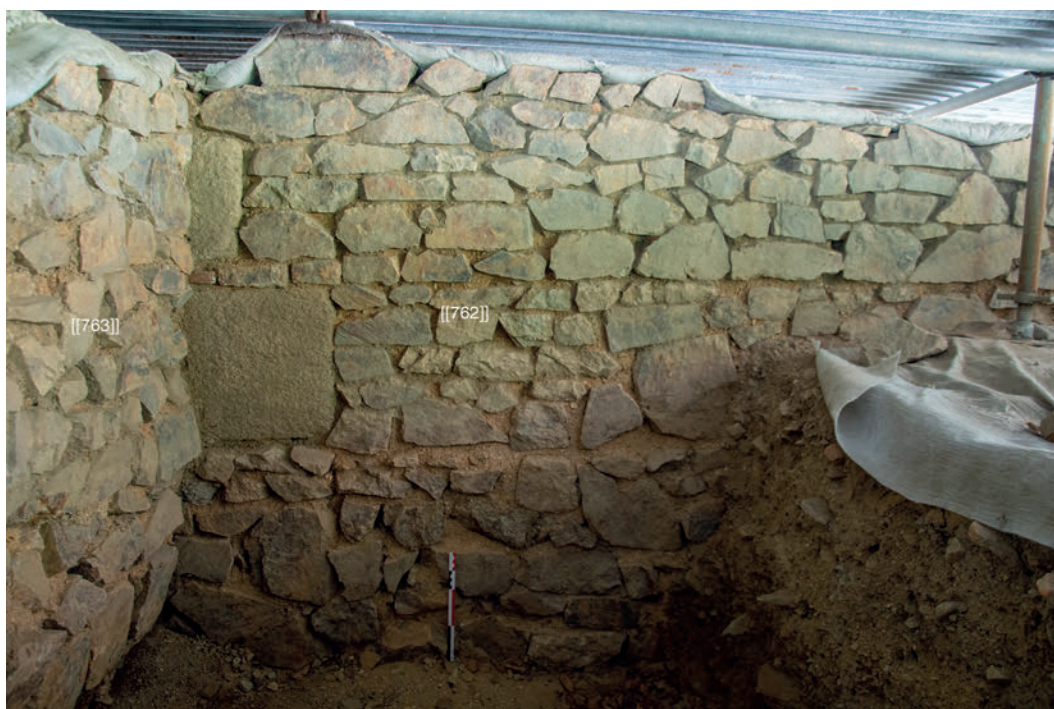
30. BibRACTE, Mont Beuvray. La domus PC2. Vue vers l'ouest des blocs de granit de grand appareil visibles dans le mur [[762]]. Le mur [[763]] n'est pas chaîné avec le reste des maçonneries, (cliché N. Scavone).
