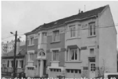
Rue de la Parmentière, immeuble années 40
