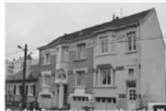
Rue de la Parmentière, immeuble années 40
