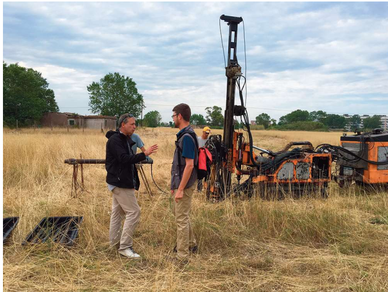
Photo des opérations de carottage en cours / Foto delle operazioni di carotaggio in corso (Photo L. Guinebault).
