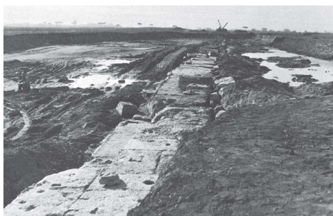
Le môle septentrional en cours de fouille en 1959 / Il Molo Settentrionale in corso di scavo nel 1959 (d'après/da Testaguzza 1970).
