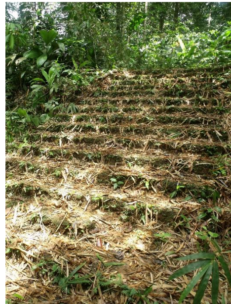
Figure 19 : escalier monumental de La Caroline
