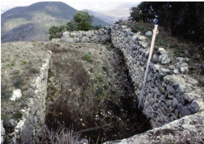
Fig.5. Etat de la construction interprétée comme une tour, avant la fouille archéologique de 1986 (Cliché L. SCHNEIDER 1986).
