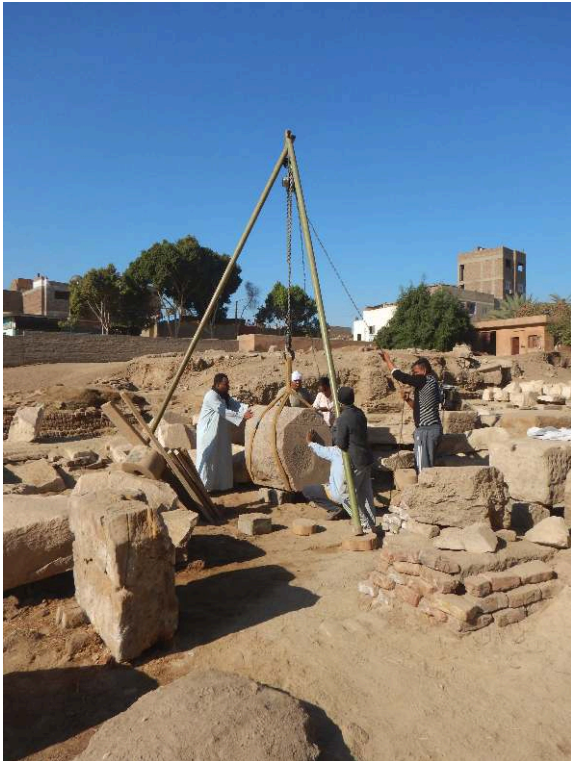
Fig. 19. Stockage provisoire d'un bloc de granite (Sésostri III) sur des plots en béton (C. Thiers).
