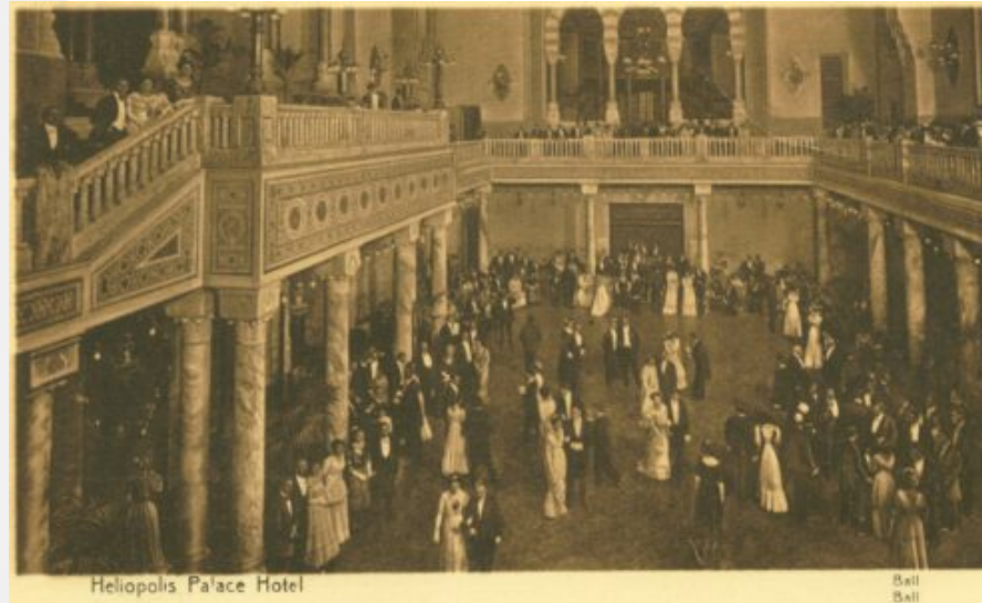
Fig. 3. Heliopolis Palace Hotel, intérieur et salle de bal
