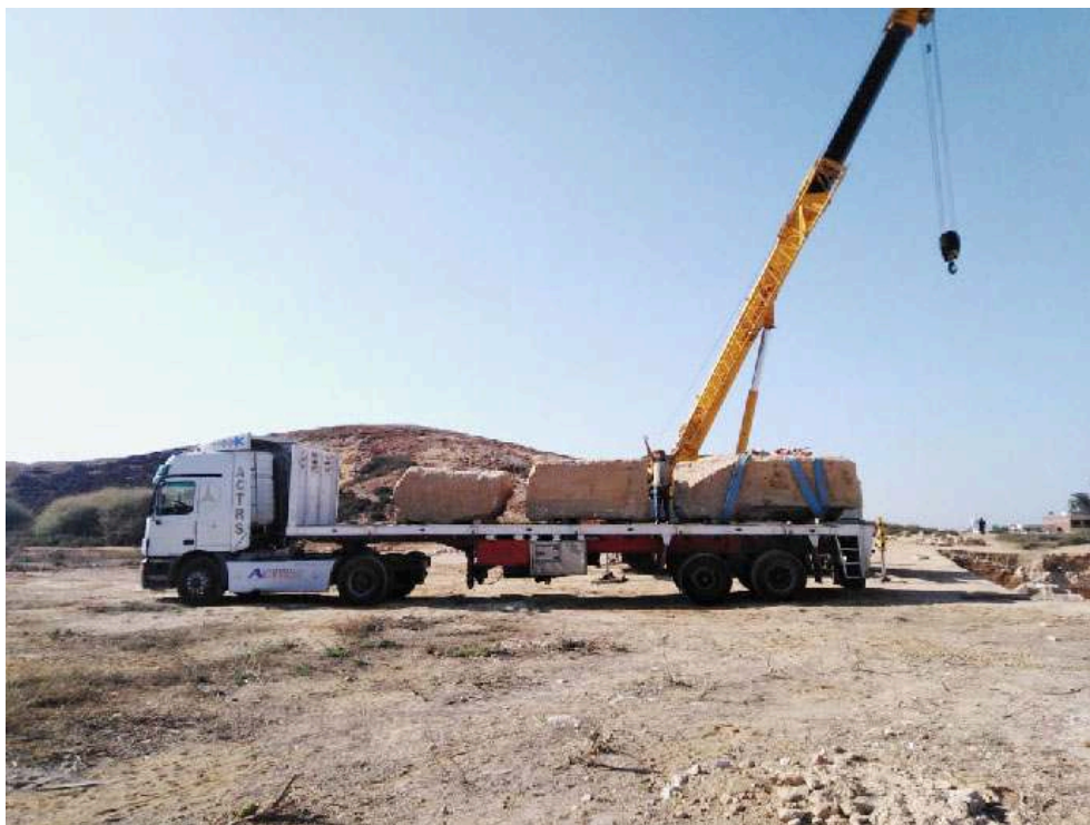
Fig. 4. Kôm Bahig. Opération de levage des blocs du sondage 20000 menée le 22 juin 2021 (K. Machinek).
