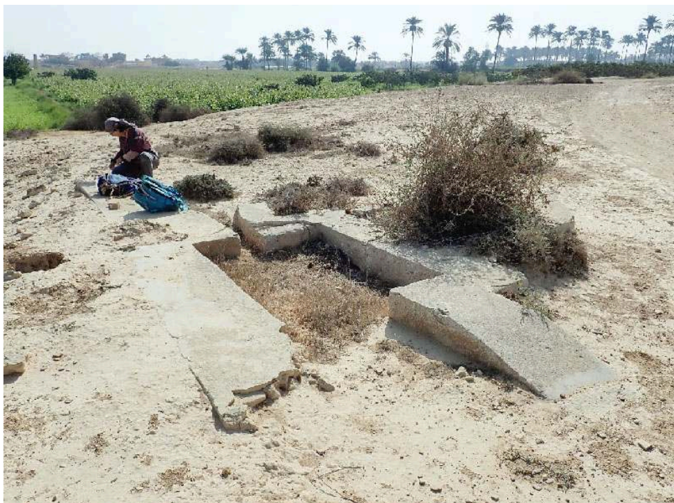
Fig. 43. Carte archéologique de la Maréotide. GMR0209, secteur 5, structure hydraulique vue depuis l'ouest (I. Awad).
