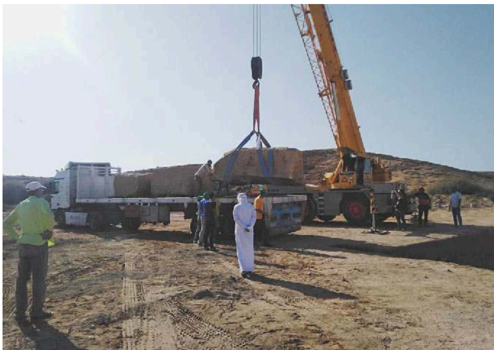
Fig. 3. Kôm Bahig. Opération de levage des blocs du sondage 20000 menée le 22 juin 2021 (K. Machinek).
