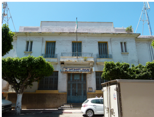
pl. XIV - Façade de la Poste élevée vers les années 1920. (© A. Charpentier)
