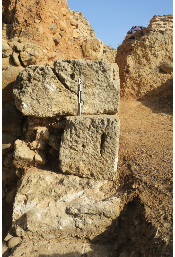
Fig. 10 : Faces de joint latéral à l'extrémité sud de la face est (4c) (Us 3005) (Photo : P. Fontaine)
