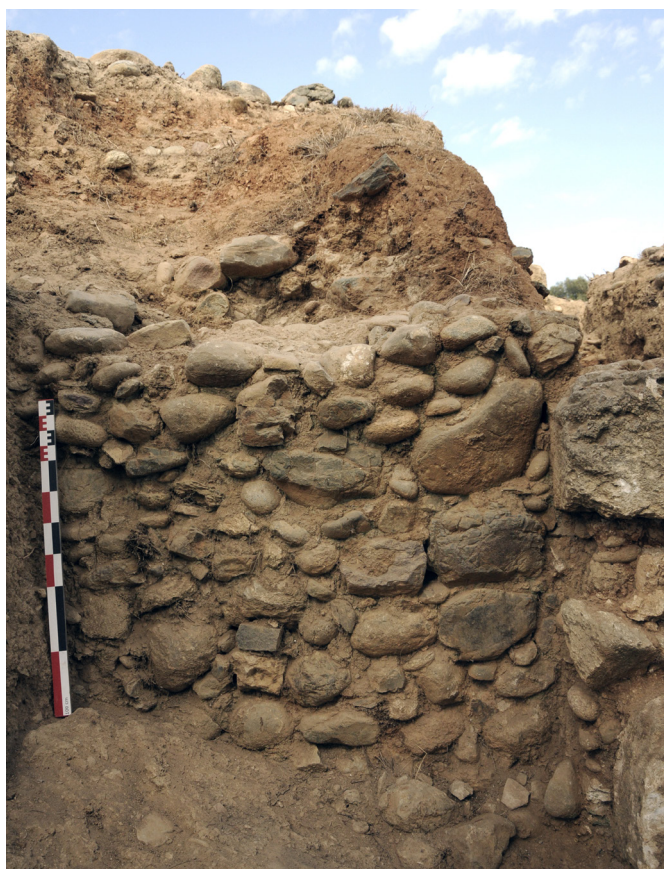
Fig. 44 : Vue du mur MR3082 depuis le sud (photo : A. Jamai)
