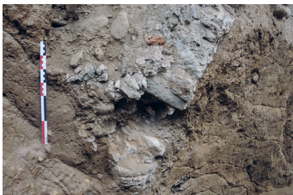
Fig. 49 : Coupe nord du sondage 1. Vue depuis le sud-ouest du massif maçonné correspondant à la base du mur MR2061. Détail de la tranchée de fondation entaillant les niveaux antérieurs ainsi que le substrat (photo : E. Gaillardrat)
