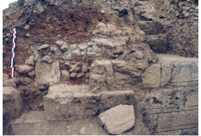
Fig. 31 : Vue de détail de la coupe 1, depuis l'est, avec le mur MR3078 surmontant le remblai 3016 (photo : A. Jamai)
