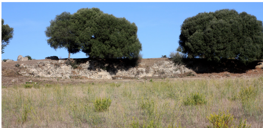
Fig. 45 (ci-contre) : Vue depuis l'est de la portion de l'enceinte romaine encore en élévation sur la frange orientale du site (photo : P. Fontaine)
