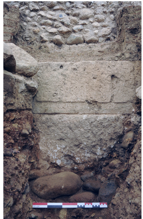
Fig. 14 : Vue de détail, depuis l'est de l'assise en pierre du rempart hellénistique, comprenant un radier de gros galets associé à un blocs taillé en réemploi et une assise à bossage (photo : E. Gailledrat).
