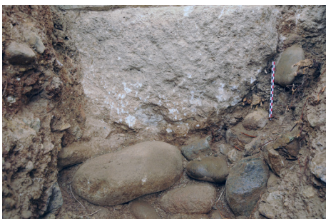
Fig. 13 : Vue de détail, depuis l'est, de la mise en œuvre de la base du parement externe du rempart hellénistique. La première assise repose sur radier de gros galets (2023) venant en débord et compensant l'irrégularité de la face de pose du bloc (photo : E. Gailledrat)
