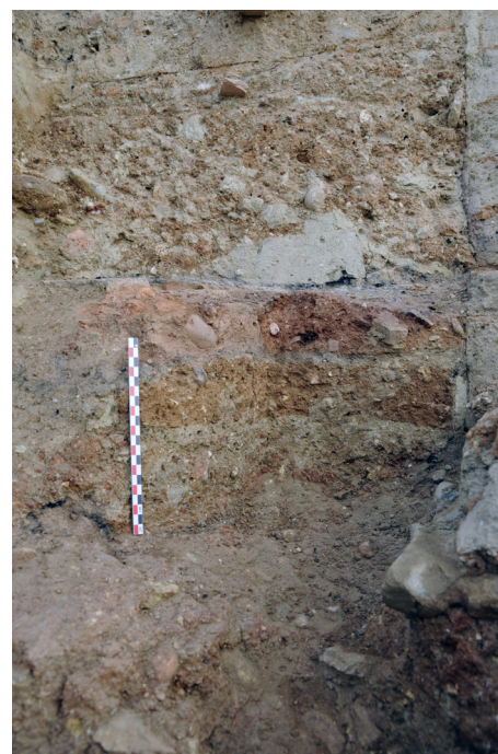
Fig. 17 : Détail de l'élévation en brique crue 3081, surmontée d'un niveau rubéfié sur lequel est tombé une poche d'enduit (photo : A. Jamai)
