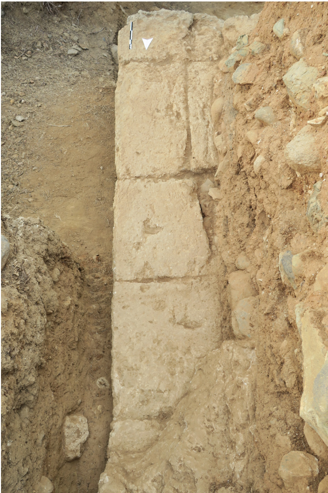
Fig. 9 : Vu de haut, le lit d'attente de la 2ème assise du parement est de la tour, extrémité sud (4c) (Us 3005). Un trou de pince au milieu du bloc central, un autre sur l'arête sud du bloc suivant, dans le bas du cliché (Photo : P. Fontaine)
