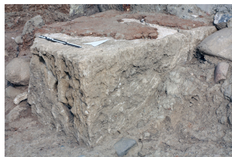
Fig. 11 : Vue de détail du bloc (3067) marquant le départ de la courtine orientale (MR3055=MR1119) au contact de la tour. Le bloc est surmonté des restes du lit de pose de la première assise d'adobes (photo : P. Fontaine)
