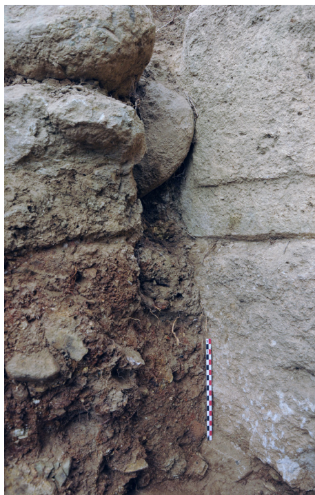
Fig. 22 (ci-contre) : Détail, depuis le nord, de la même séquence (face S). Dans la partie inférieure, la levée de terre (2011) venant s'appuyer contre la première assise de blocs. Au-dessus, le remblai (2020) ainsi que le blocage de galets (2023) soigneusement agencé contre l'assise supérieure (photo : E. Gailledrat)
