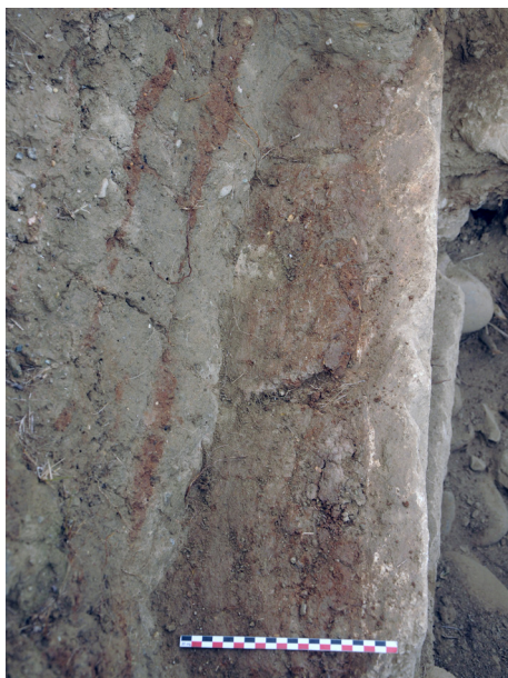
Fig. 16 : Vue de détail, zénithale, du lit d'accroche d'argile sableuse rougeâtre à la base de l'élévation en adobes de la fortification hellénistique (photo : E. Gailledrat).
