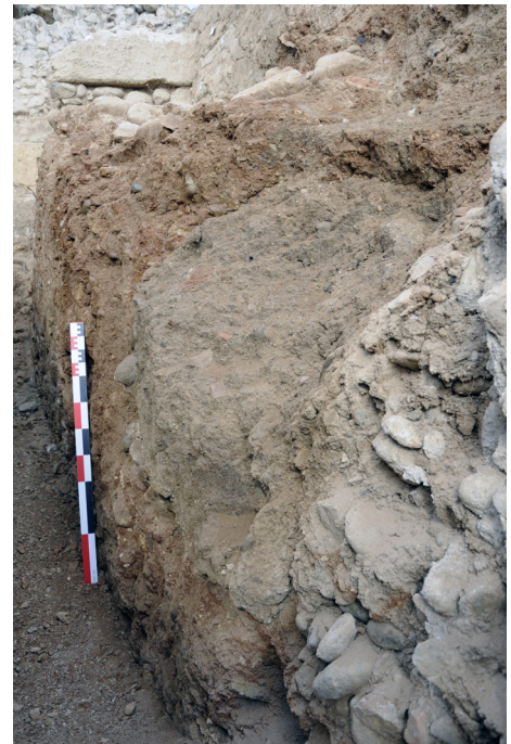
Fig. 50 : Coupe nord du sondage 1. Détail, depuis le sud-ouest, du colmatage du vide laissé par l'effondrement du mur MR2030 (photo : E. Gailledrat)
