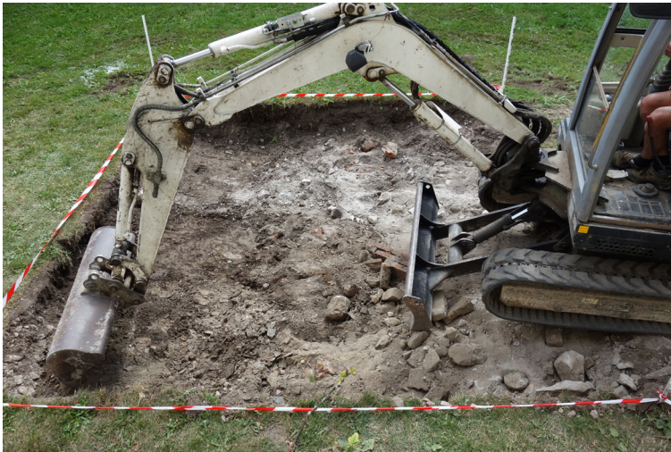
Fig. 24 - Décapage en cours et apparition de la couche de démolition US 40 002 (briques, pierres).
