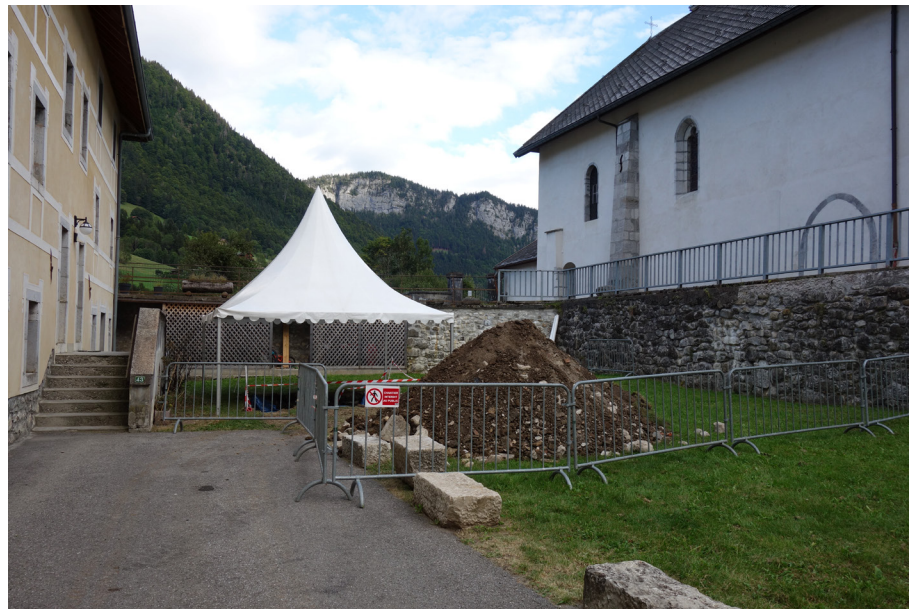
Fig. 19 - Sécurisation du chantier par des barrières et panneau «Chantier interdit au public».
