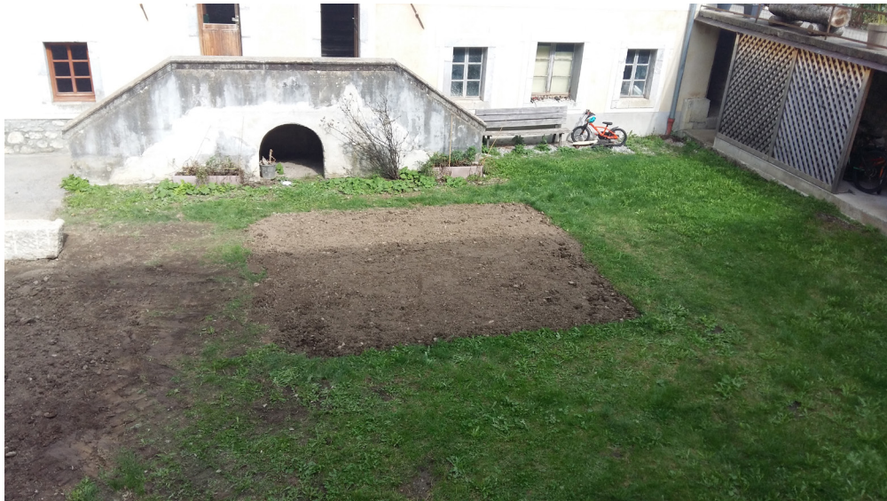
Fig. 23 - Sondage rebouché au pied des escaliers d'accès à l'aile nord. À droite, emplacement de l'ancienne aile orientale remplacée par un abris de jardin.
