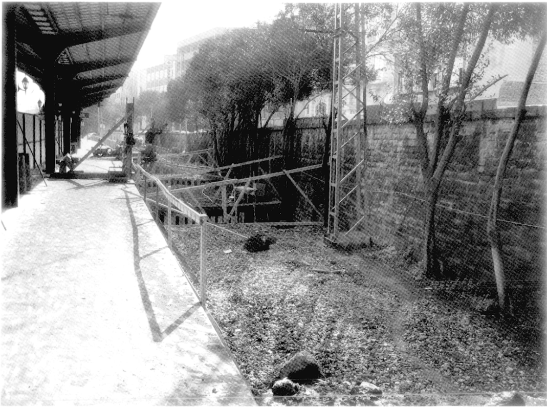
Fig. 4 : Sondages à l'intérieur de la gare ferrovière de Sirkeci.
