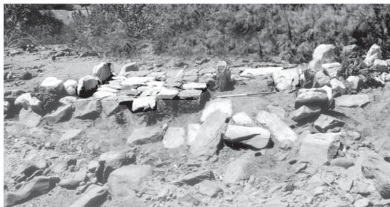
Figure 14. Al-Ḥuwaydar. Vue des deux seuils du déversoir de crue (cliché mission archéologique française de Ḍura').
