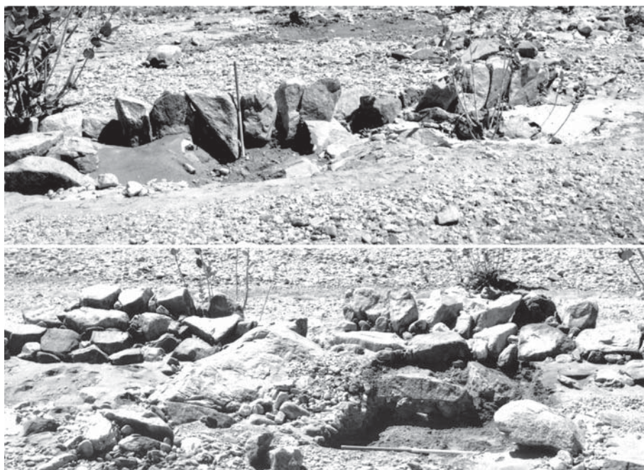
Figure 21. Mise en œuvre des talus du mur déflecteur e2 (cliché mission archéologique française de Ḍura').
