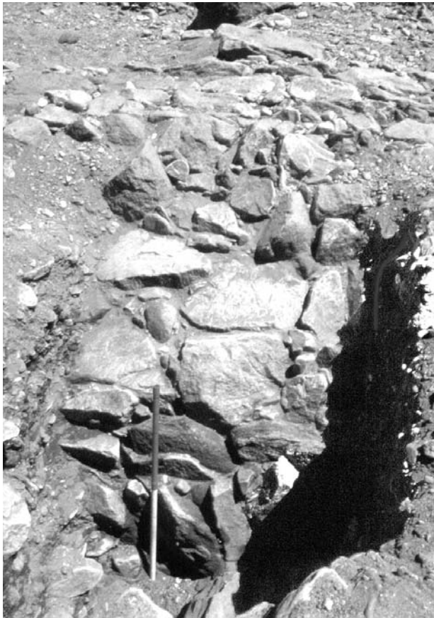
Figure 16. Marbun. Vue du talus aval et du sommet du barrage (cliché mission archéologique française de Ḍura').
