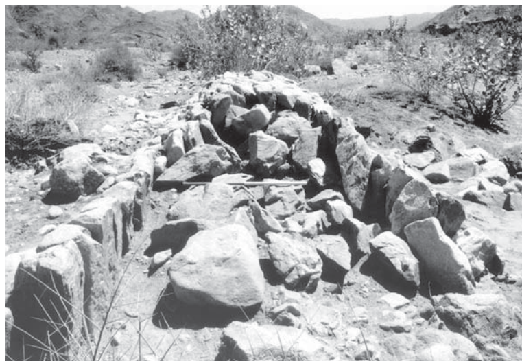
Figure 20. Détail du blocage interne du mur déflecteur e1 (cliché mission archéologique française de Ḍura').
