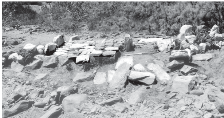
Figure 14. Al-Ḥuwaydar. Vue des deux seuils du déversoir de crue (cliché mission archéologique française de Ḍura').
