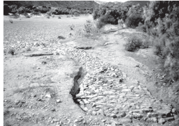
Figure 28. Mukayl. Queue arrondie à l'extrémité aval du mur déflecteur 1 largement recouvert par les dépôts du wādī (cliché mission archéologique française de Ḍura').
