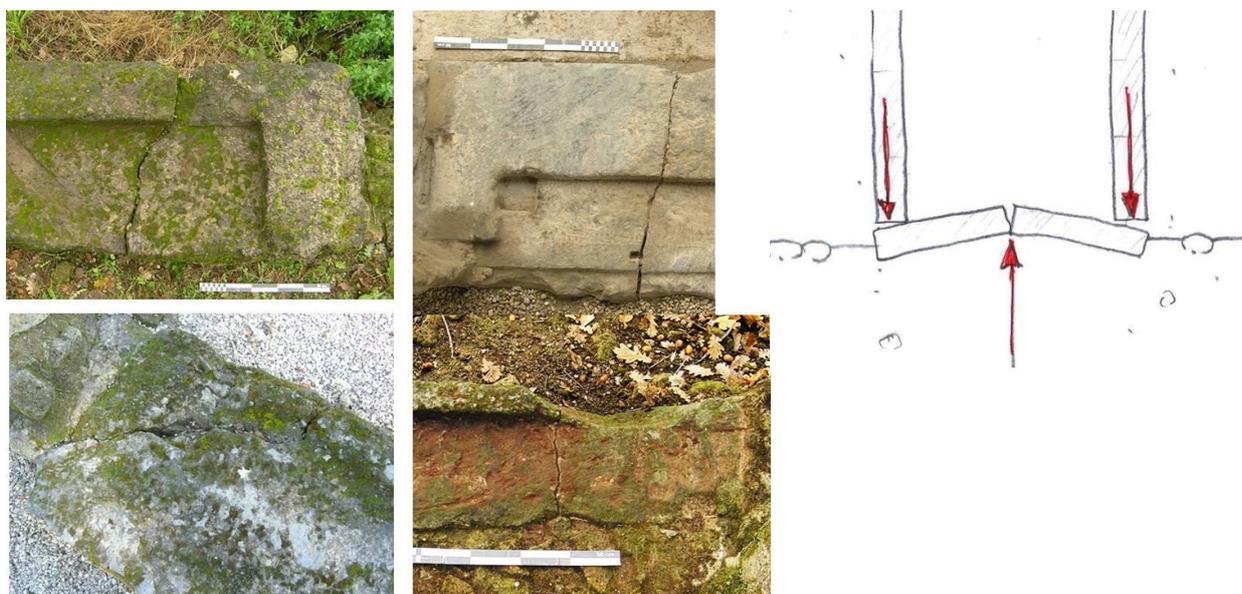
Fig. 5 : seuils brisés à la suite de tassements différentiels
