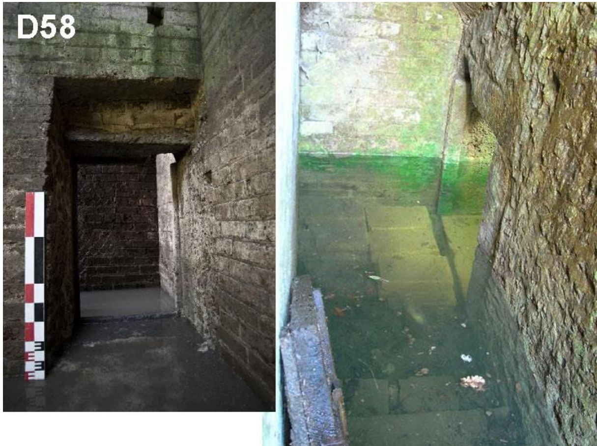
Fig. 6 : porte du monument D58. Intérieur à gauche, extérieur au pied de l'escalier d'accès à droite.
