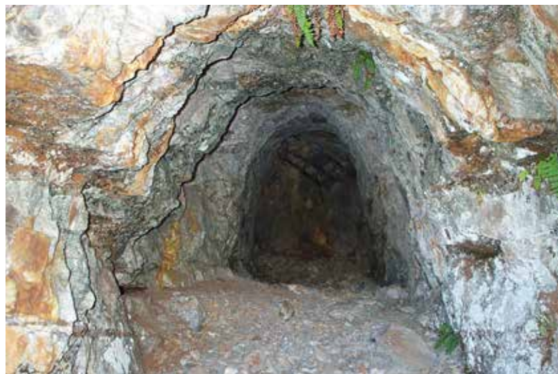
Fig. 13 : Exemple de galeries d'extraction de quartz hyalin taillées à la poudre en Oisans (Isère). Les Grandes Buffes 3 au Freney d'Oisans (38) à 1 650 m d'altitude. (Clichés : É. Thirault, 1 er novembre 2006).
