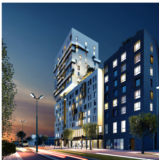
Perspective nocturne du programme Triangle Ouest (Noisy le Sec) Projet IMGPI porté par Linkcity Île-de-France Illustration : Luc Izri
