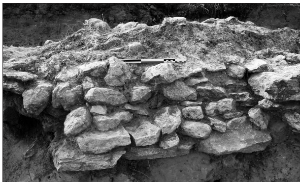
Fig. 5 : Radier de la chaussée Jules-César à Commeny "La Porte de Mantes" (photographie S. Robert-CG95/DAC/SDAVO 2009).
