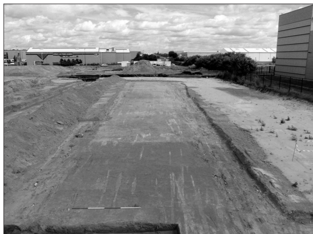
Fig. 11 : Ornières antiques mises au jour sous l'empierrement de la voie (Phases b à d de la Fig. 9).
