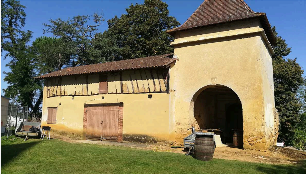
Fig. 2. Sainte-Christie d'Armagnac (Gers), enduit lissé sur structure bois et terre (cl. Mathias Dupuis)
