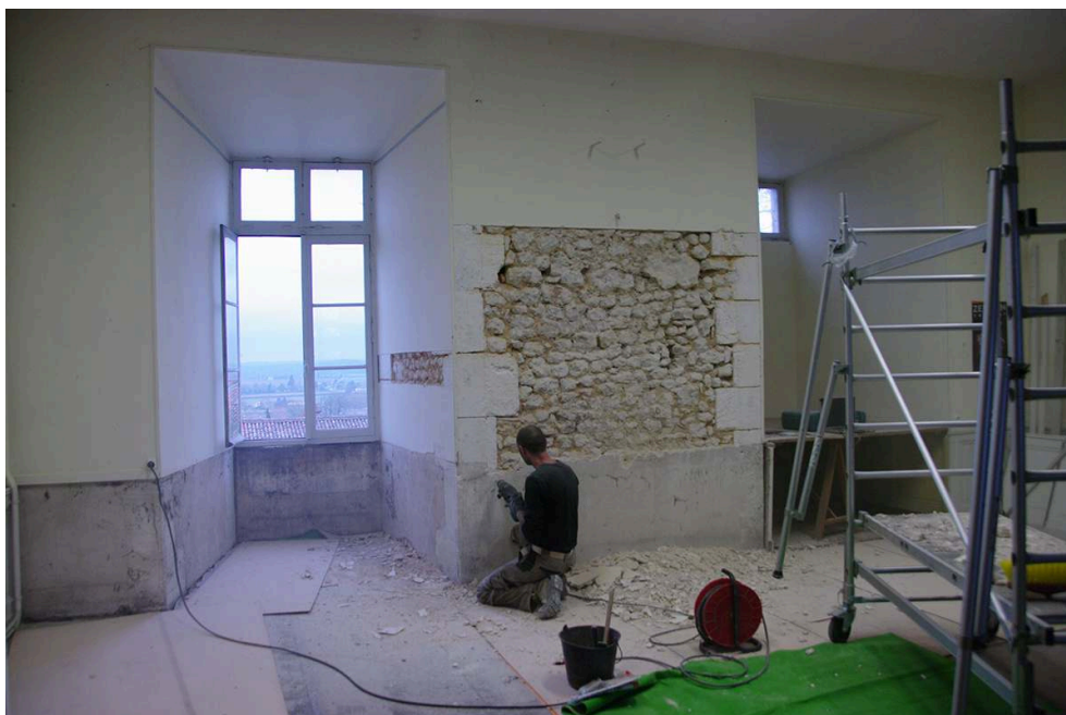
Fig. 6. Barbézieux-Saint-Hilaire (Charente), château, décroûtage des élévations dans le grand logis, dans le cadre d'une opération d'archéologie préventive, fouille Mathias Dupuis, 2011 (cl. M. Dupuis).
