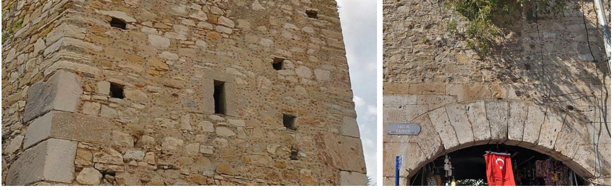
Şekil 15-16. Kuşadası Şehir Surları altıgen planlı köşe kulesi ve kapı biriminden duvar işçiliği ve derz detayı.
