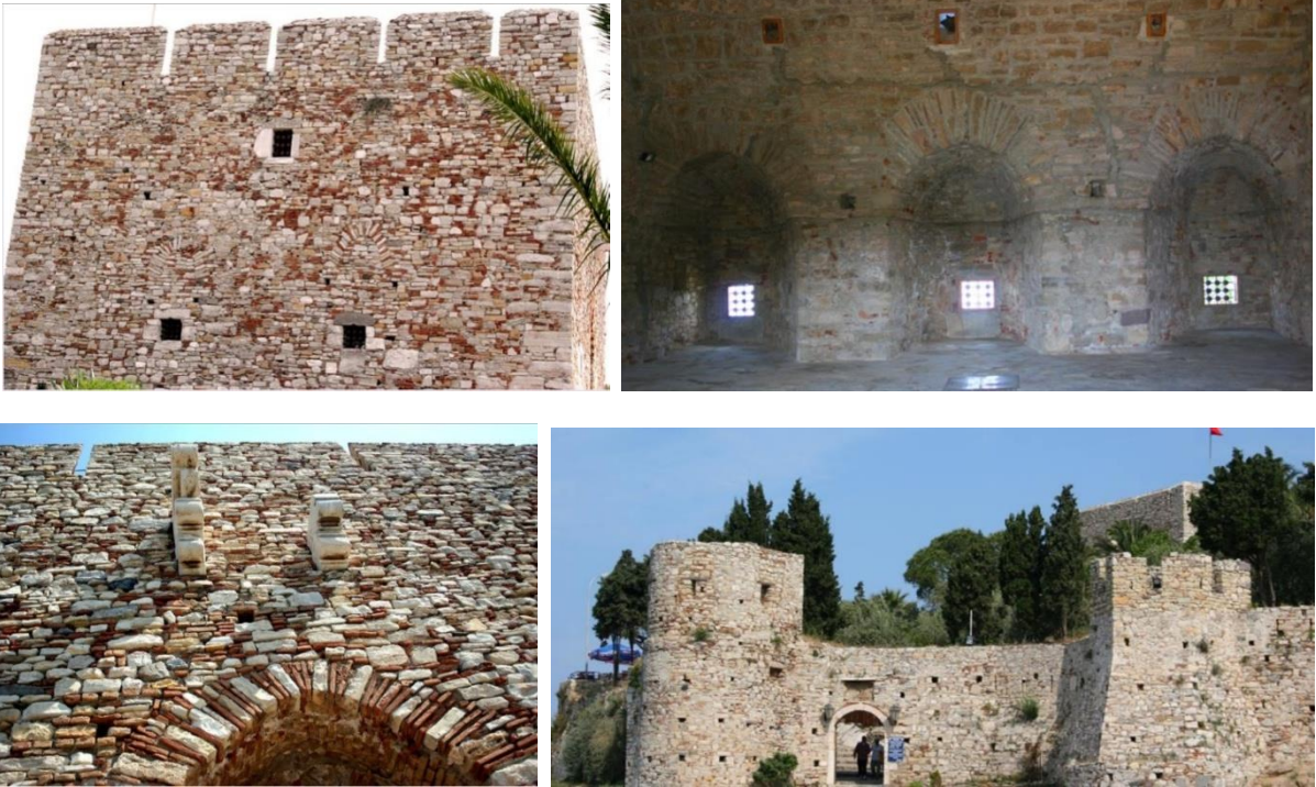
Şekil 4-7. Güvercinada Kalesi kule yapısının batı cephesi dıştan; kuzey cephesindeki top mazgalları içten; güney cephesindeki ana girişinden detay; ve dış surlardaki çift kuleli ana giriş ile geride ana kule (M. Halit Umar, 2006)
