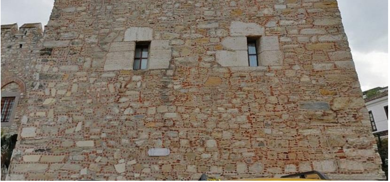
Şekil 19. Öküz Mehmed Paşa Kervansarayı'nda sahile yönelen burcun ön cephesi.
