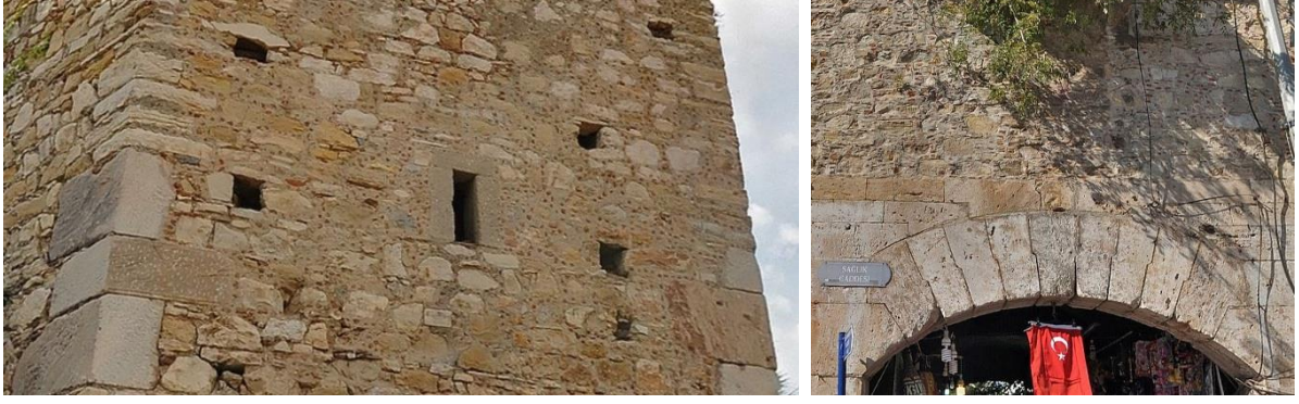
Şekil 15-16. Kuşadası Şehir Surları altıgen planlı köşe kulesi ve kapı biriminden duvar işçiliği ve derz detayı.
