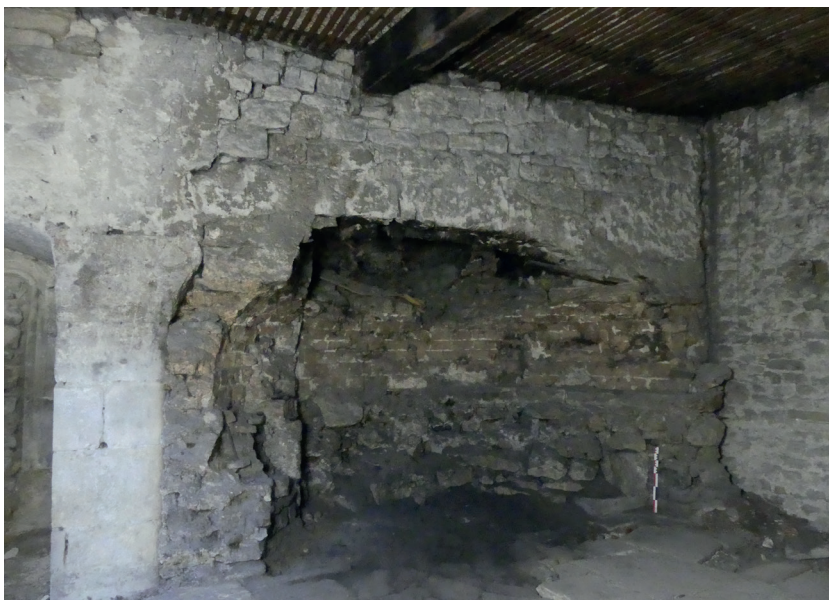
Fig.19 La cheminée CH1002 de la pièce 15, en pierre blanche, dont on peut surtout observer le pilier de gauche et le départ de l'arc. La reprise en briques réfractaires remonte à sa transformation en four. Vue du sud-ouest.
