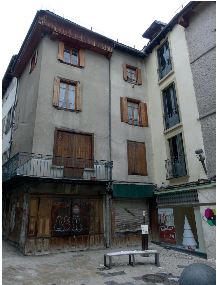
Fig.34 La place au Beurre vue du sud-est et la façade orientale du début du XIX e siècle de la maison Peytavin (à gauche, à deux travées). Inrap cliché L. Wozny
