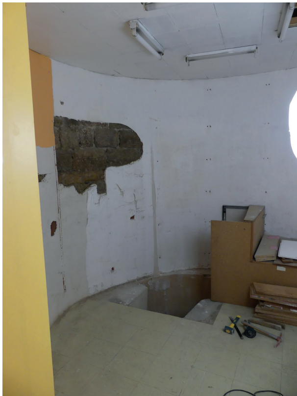
Fig.11 La cage de l'escalier ES1007 au rez-de-chaussée. Les deux premières révolutions ont été déposées et celle qui conduisait à la cave a été remplacée par le petit escalier droit dont on voit la trémie au fond au centre du cliché. On note à gauche, sous l'enduit, l'appareil en pierre de taille du mur MR1010. Vue de l'ouest.
