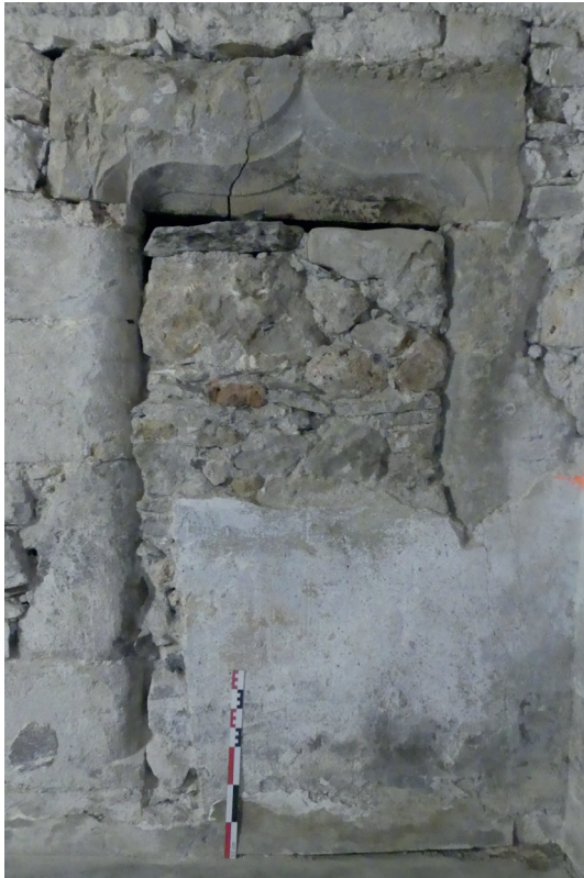
Fig.32 La porte 1201 entre la loge 07 et la pièce 08, au rez-de-chaussée de la maison Peytavin. Vue du sud. Inrap cliché O. Mauftras
