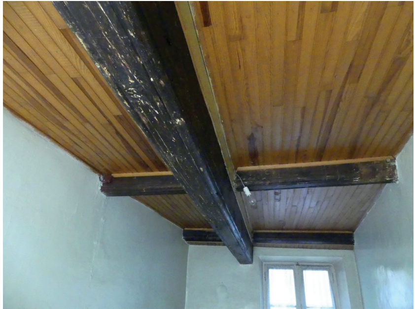
Fig.6 Le plafond PL1034 de la pièce 11 au premier étage de l'aile sud de la maison Raynal : partie occidentale vue du nord. Inrap cliché L. Wozny
