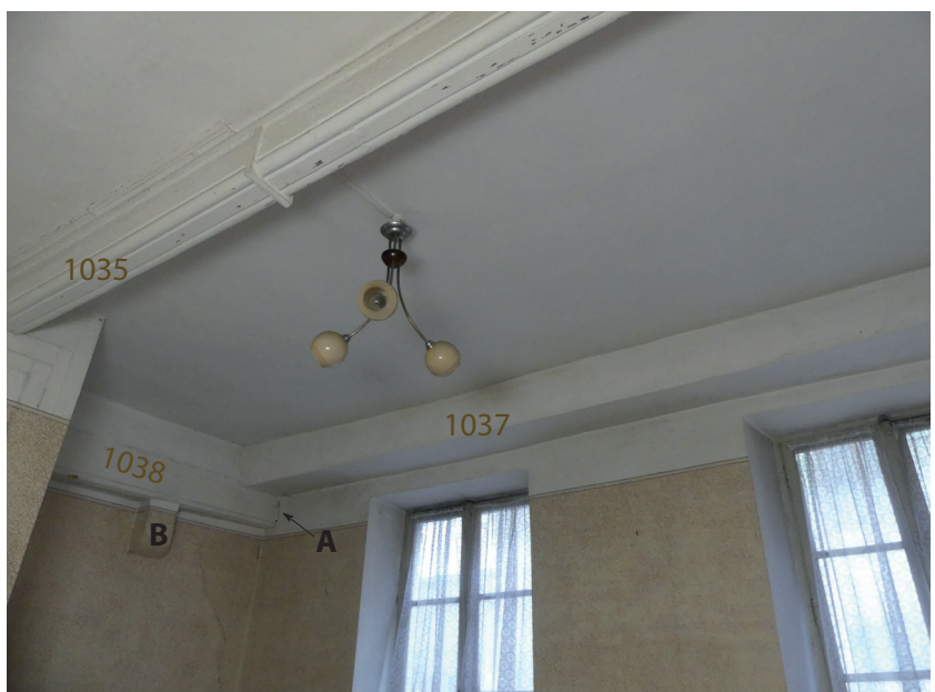
Fig.8 Le plafond PL1034 de la pièce 11 au premier étage de l'aile sud de la maison Raynal : partie orientale vue du nord-ouest. A : trace de sciage de la poutre 1038. B : console d'appui de la poutre probablement posée juste avant de la sectionner. Inrap cliché L. Wozny
