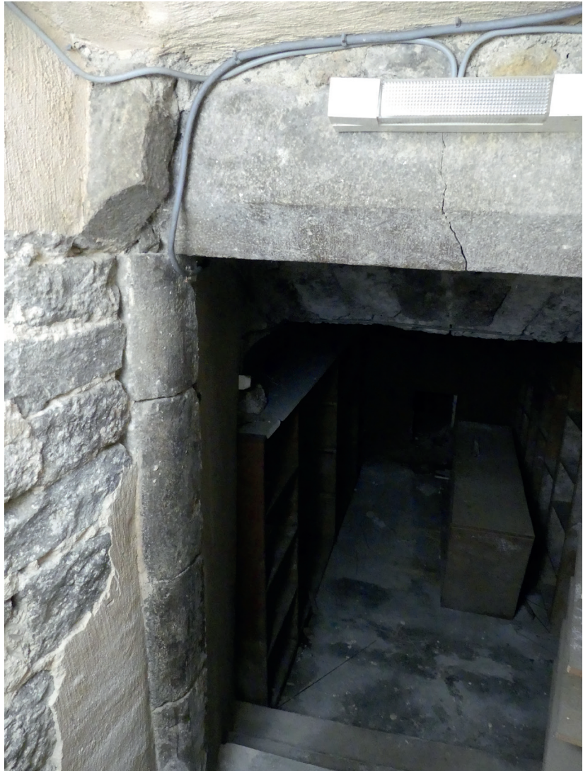
Fig.9 La porte 1048 entre l'escalier en vis et la cave C1, en sous-sol de la maison Raynal. Vue du nord. Inrap cliché O. Maufrais
