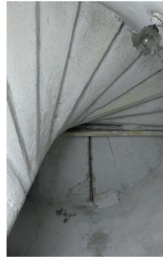
La dernière révolution de l'escalier monumental de la maison Raynal au XV e siècle et son palier sommital, vus de dessous Cl. L. Wozny
