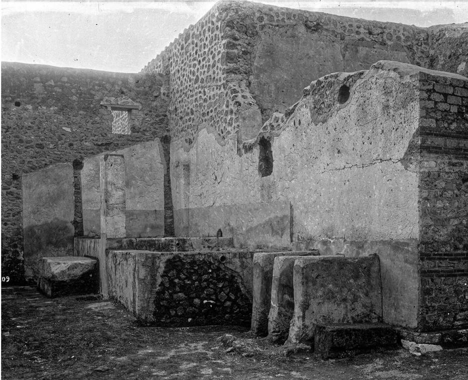
Outre les enduits dans un état de conservation remarquable, on note la présence de deux tuyaux de vidange du trop-plein des bassins de rinçage, un cordon maçonné en avant des stalles, et un bloc de calcaire du Sarno contre la plus orientale de celles-ci. Vue de l'est.
