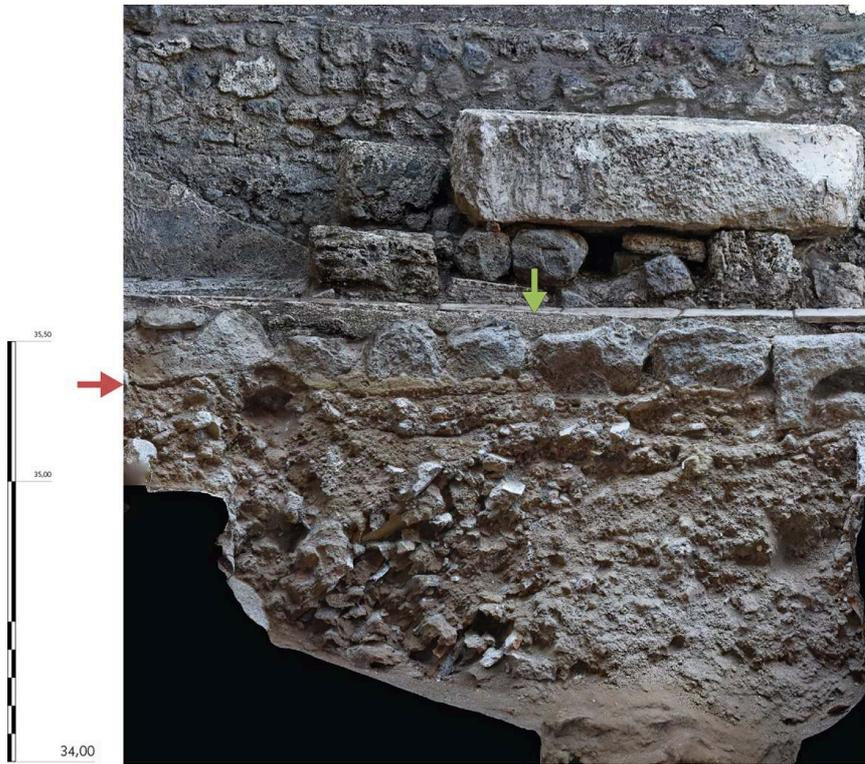
La flèche rouge indique la base du mortier terreux caractérisant la portion occidentale, tandis que la flèche verte marque sa limite à l'est. Vue photogrammétrique du sud.
