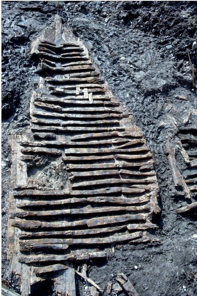
Fig. 95. Toulon 3-4 . Vue depuis le nord-ouest de la charpente transversale (cl. archive CAV).
