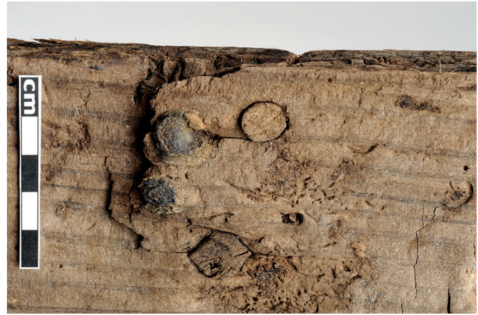
Fig. 21. Toulon 1 . Vue de détail de la tête de trois petits clous utilisés pour réparer une fissure au niveau d'une mortaise (cl. L. Damelet, CCJ/CNRS).
