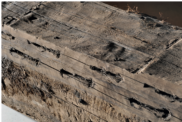
Fig. 86. Toulon 3-4. Détail du double chanfrein de la quille (cl. L. Damelet, CCJ/CNRS).
