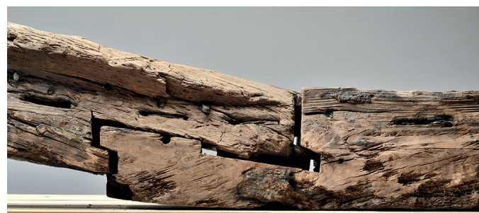
Fig. 123. Toulon 7. L'enture unissant la quille (à droite) au brion (à gauche) (cl. L. Damelet, CCJ/CNRS).
