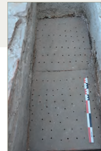
■ Briques perforées constituant le fond d'une sépulture de l'annexe nord de la basilique.
