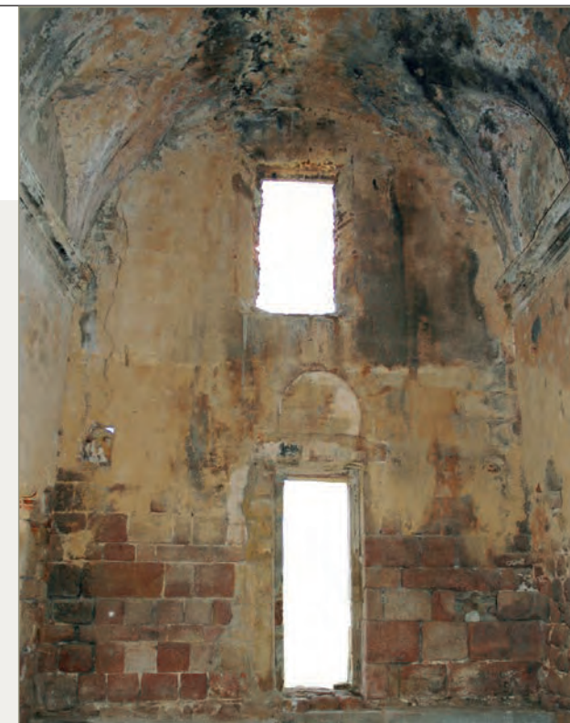
■ Le mur nord de la chapelle du XVIII e siècle.
