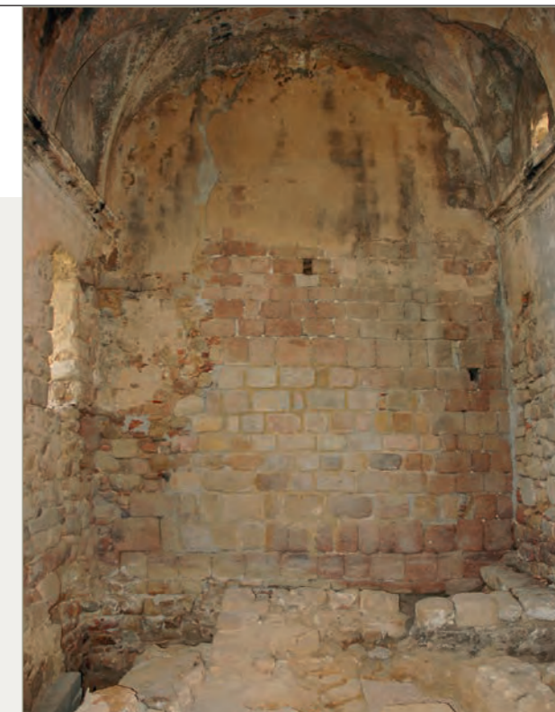
■ Le mur sud de la chapelle du XVIII e siècle.
