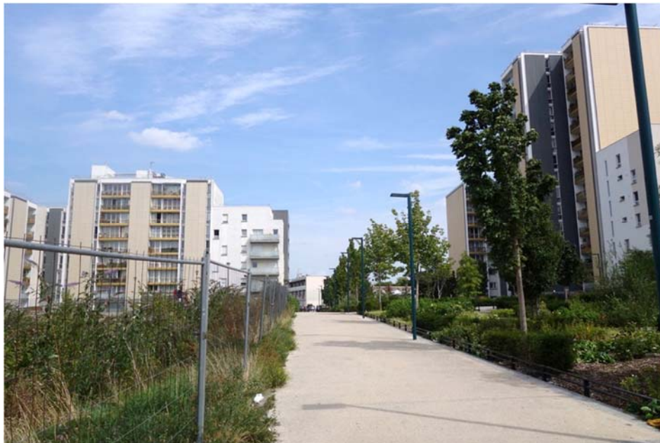
Figure 12 : la Cité Rouge de Gennevilliers après rénovation.
