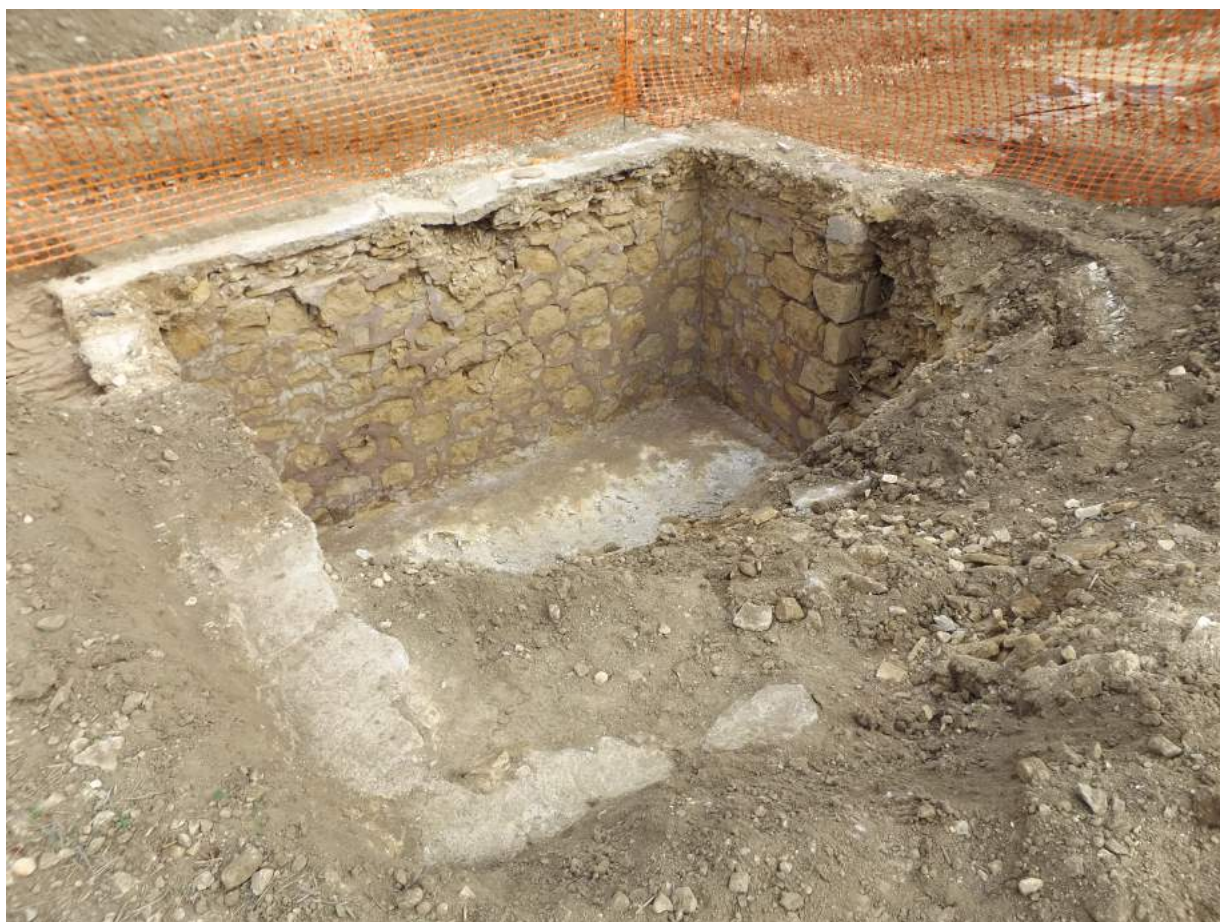
FIG. 3: Bretteville-sur-Odon : Abri enterré allemand en cours de fouille réalisé en moellons calcaire. Cet élément faisant partie intégrante du Mur de l'Atlantique interpelle par la nature des matériaux employés pour sa réalisation. © Benoît Labbey, INRAP.
