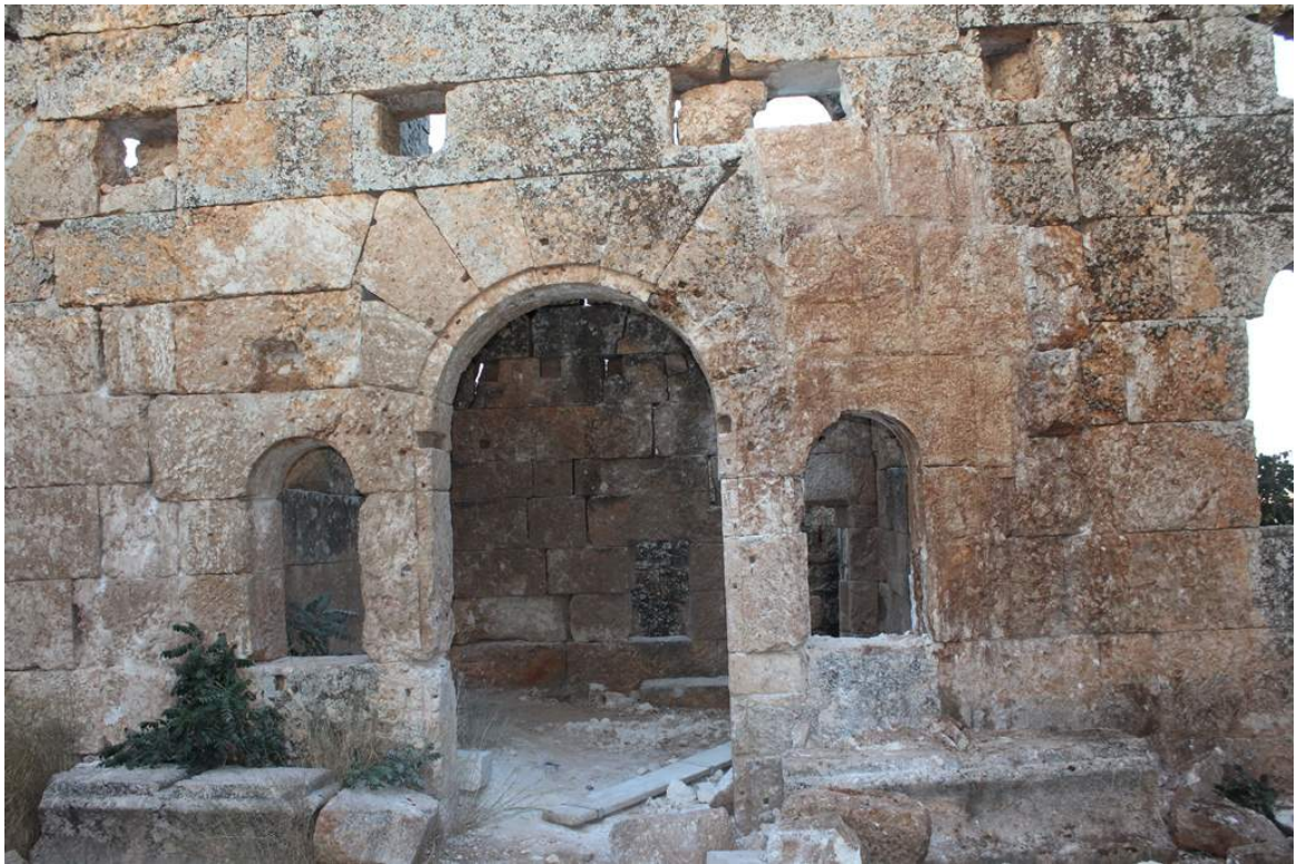
FIG. 17: Deir Soubat : sauvetage du monastère, consolidation de la façade en remplaçant les blocs manquants (© Idlib Antiquity Center).
