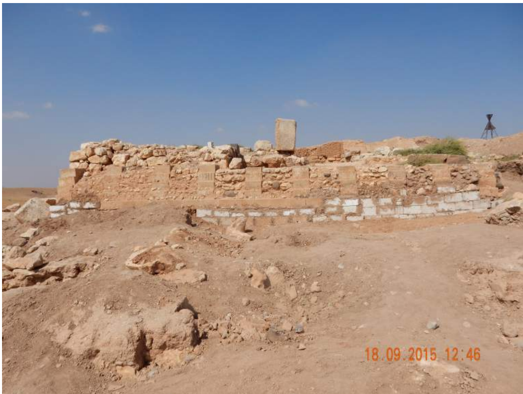
FIG. 16: Ebla : consolidation de l'entrée du temple D (Grand temple), avant et après l'intervention (© Idlib Antiquity Center).
