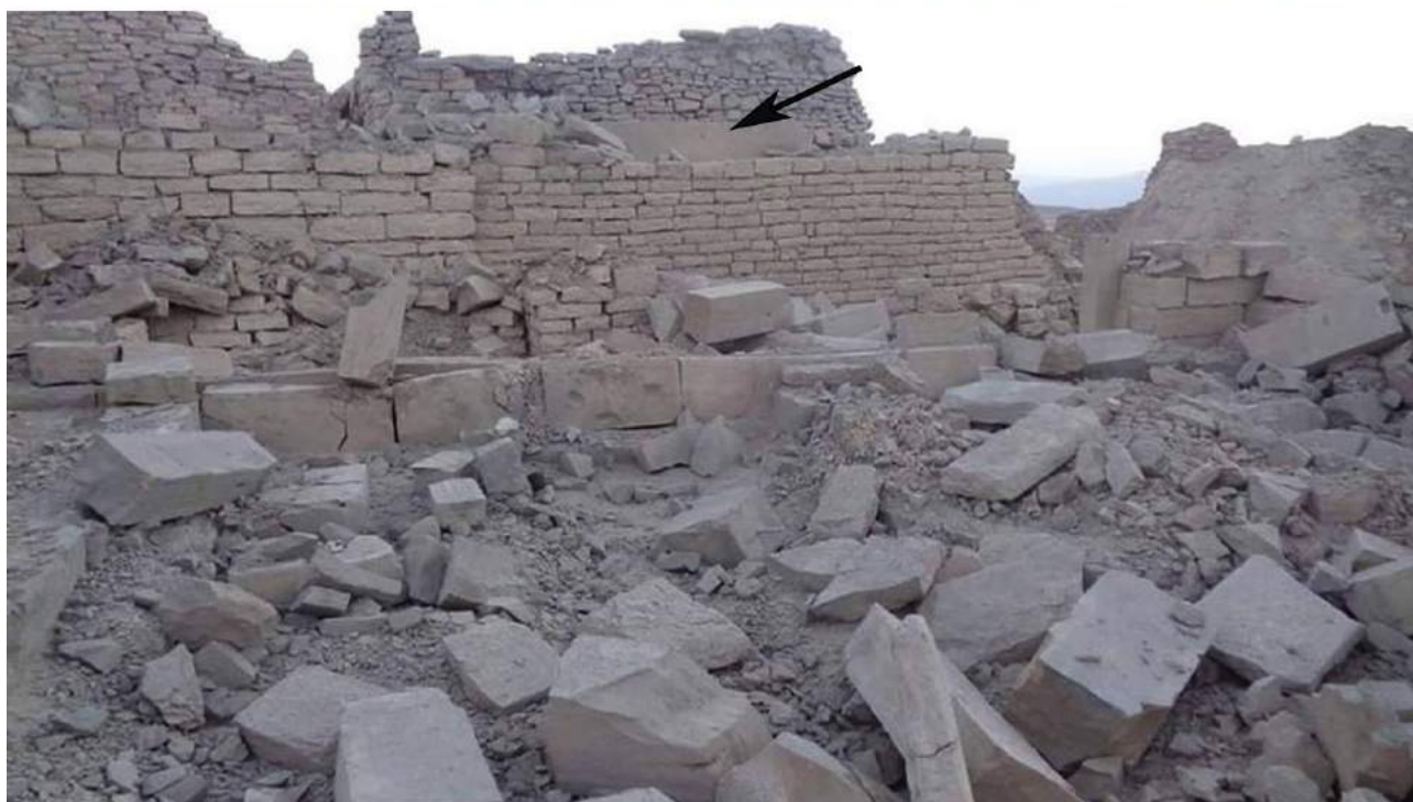
FIG. 21: Barāqish, temple de Nakrah après sa restauration en 2006 (haut) et après bombardement aérien en 2015 (bas). La flèche noire fournit un repère commun aux deux photographies (haut : J. Schiettecatte ; bas : GOAM).
