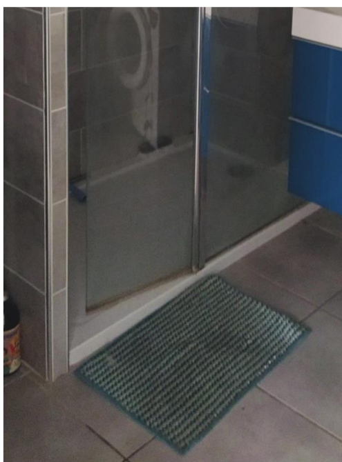
Refaire les joints (Julie et Guillaume)
