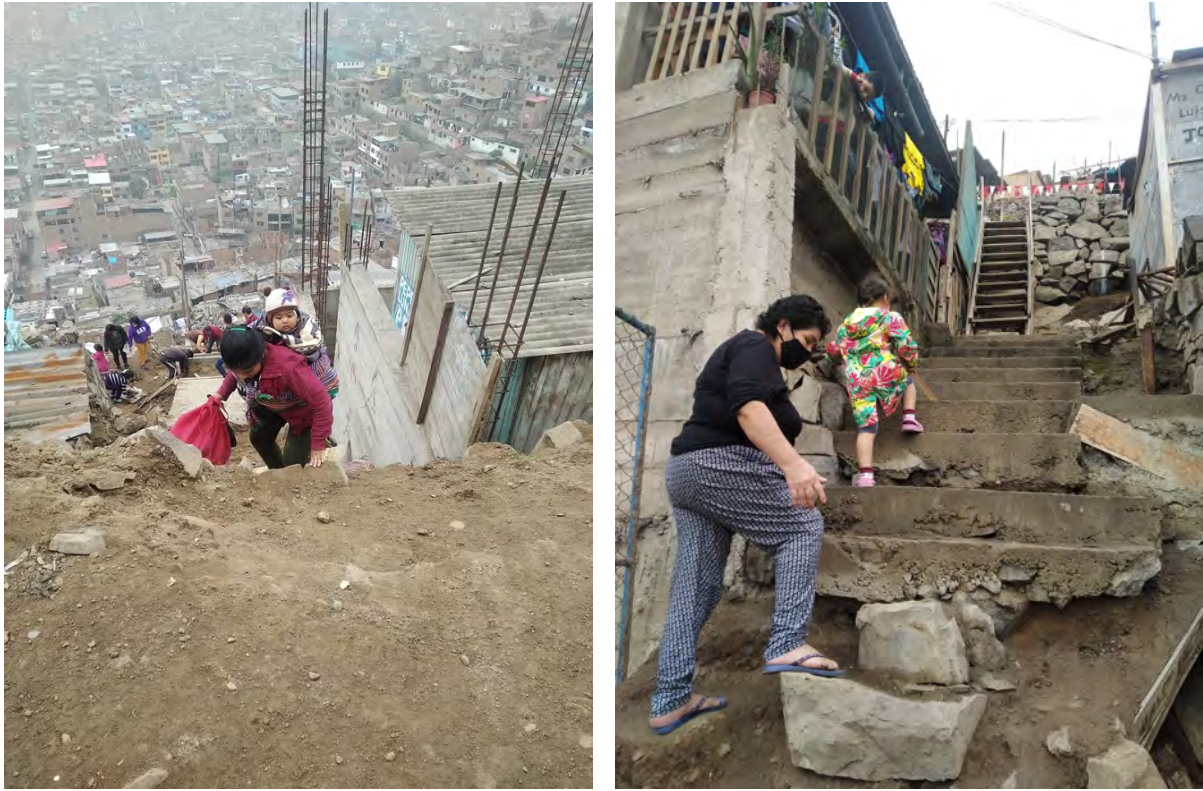
14. Dans le district d'Independencia, en périphérie de Lima, les escaliers – aménagements indispensables aux déplacements quotidiens dans ce quartier à la topographie accidentée – sont le plus souvent discontinus, mettant en danger les habitants dans leurs cheminements quotidiens (Román García, ANR Modural, 2021).
