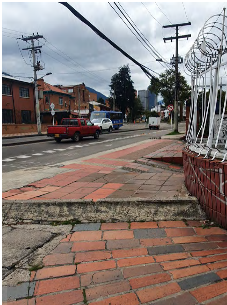
17. Trottoir discontinu avec ruptures de pente dans le quartier de La Soledad (Teusaquillo) (Ducasse, 2022).
