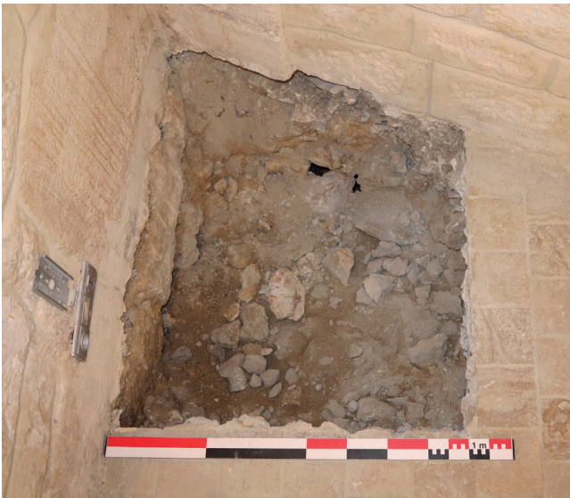
Fig. 3 Le sondage 3. Au pied du mur, la voûte entre les deux niveaux a été percée, laissant passer la lumière des caves inférieures. Cliché J. Avinain, Ville de Paris.
