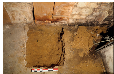
Fig. 14 Le sondage 3. Cliché J. Avinain, Ville de Paris.
