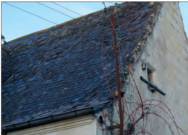
Fig. 29 - La maison actuelle, angle de la façade nord avec le mur est : on observe les rondelis, la brisure du toit et la corniche du XIX e s. @ Cliché L. Déodat 2020.
