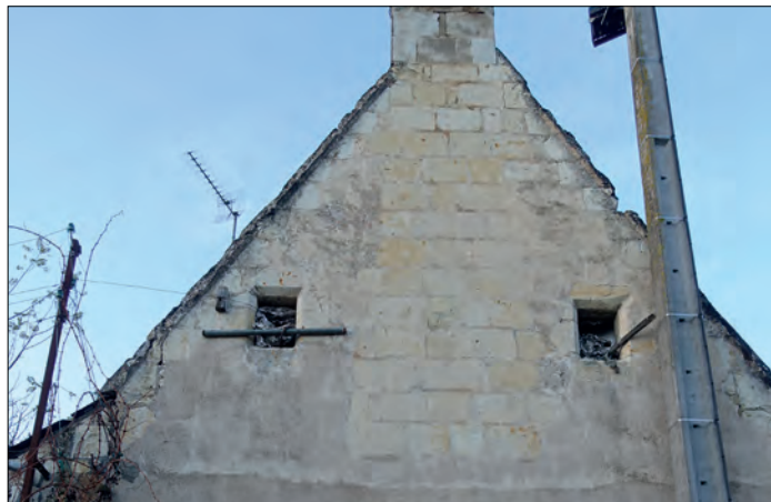
Fig. 30 - La maison actuelle, façade nord : on observe les rondelis, les petites ouvertures et la pente de la toiture d'origine @ Cliché L. Déodat 2020.
