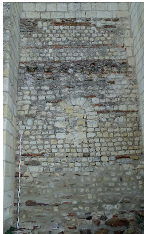
Fig. 12 - L'appareil en petits moellons de Saint-Vétérin, mur sud @ Cliché L. Déodat 2018.
