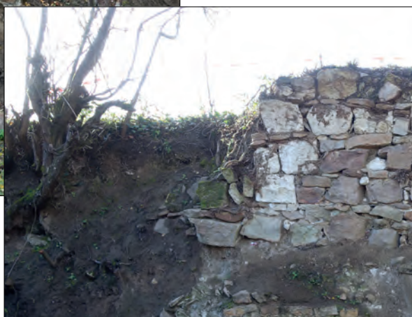
Fig. 90 - Le mur contemporain en partie éboulé à gauche, paroi 2, zone 3 @ Clichés L. Déodat 2020.
