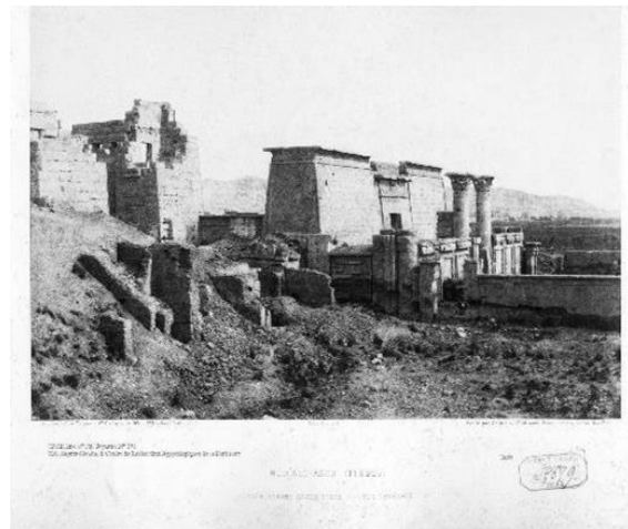
Figure 1 : F. TEYNARD, planche 34 : « Médinet-Abou (Thèbes), Constructions antérieures – Vue générale ». Tampon du Dépôt Légal Seine (1853). Numéro d'inventaire 8689.
