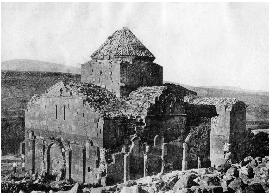
Fig. 1. Église Saint-Serge, érigée de 480 à 490 à Tékör (district de Chirak de l'ancienne Arménie, actuelle Turquie), en 1908. Ici photographiée trois ans avant le séisme de 1911, cette église, entièrement détruite depuis le milieu du XX e siècle, est l'un des plus anciens exemples datés d'église à coupole sur croix inscrite. Photo Nikolai Marr.
