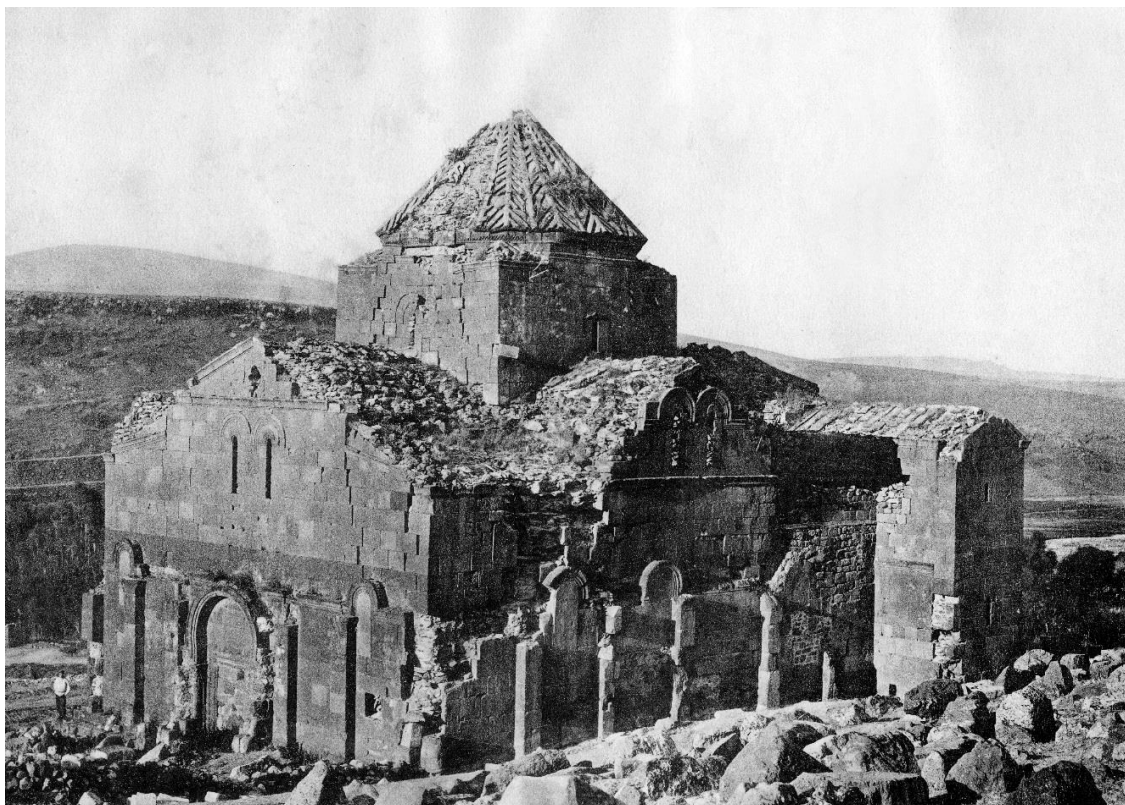
Fig. 1. Église Saint-Serge, érigée de 480 à 490 à Tékor (district de Chirak de l'ancienne Arménie, actuelle Turquie), en 1908. Ici photographiée trois ans avant le séisme de 1911, cette église, entièrement détruite depuis le milieu du XX e siècle, est l'un des plus anciens exemples datés d'église à coupole sur croix inscrite. Photo Nikolai Marr.
