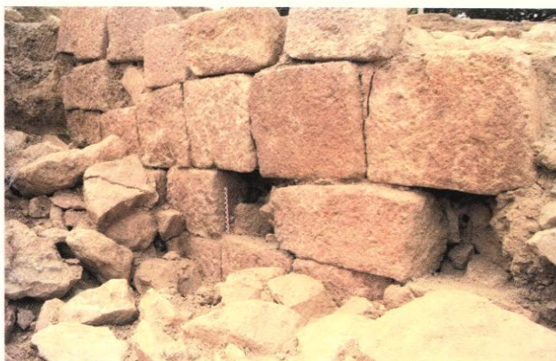
Fig. 13 : Élévation supérieure de la façade en blocs taillés du murus gallicus (cliché D. Lallemand).
