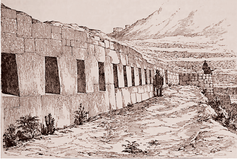
FOTO 5. Corredor con nichos en las ruinas de Ollantaytambo.
