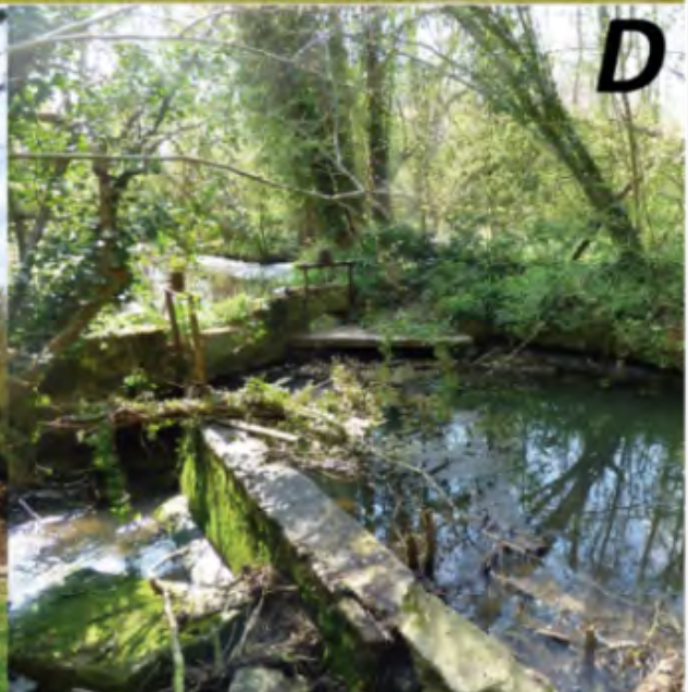
199– Aménagements hydrauliques sur le cours du Radon (moulins de dérivation et d'étang). A. « Moulin Hinier » ; B. Moulin de la Leu. Noter le biefperché (1). C et D. « Moulin de l'étang » en tête du bassin-versant du Radon. Il est alimenté en eau par un étang. À droite (D), une vanne éclusière permet de réguler le débit d'eau et d'actionner la roue meunière plus en aval [© T. Piau 2021]
