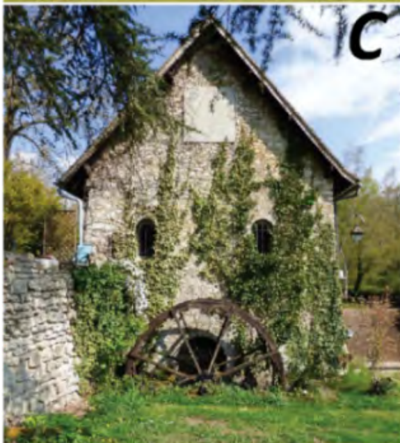
199– Aménagements hydrauliques sur le cours du Radon (moulins de dérivation et d'étang). A. « Moulin Hinier » ; B. Moulin de la Leu. Noter le biefperché (1). C et D. « Moulin de l'étang » en tête du bassin-versant du Radon. Il est alimenté en eau par un étang. À droite (D), une vanne éclusière permet de réguler le débit d'eau et d'actionner la roue meunière plus en aval [© T. Piau 2021]
