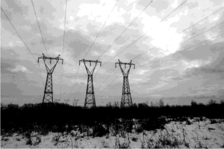
Figure 1 : La traversée du fleuve Saint-Laurent à la hauteur de la Côte-de-Beaupré et de l'île d'Orléans au Québec constitue certainement un exemple de ce changement de valeurs. Aujourd'hui, ces trois lignes sont largement décriées.
