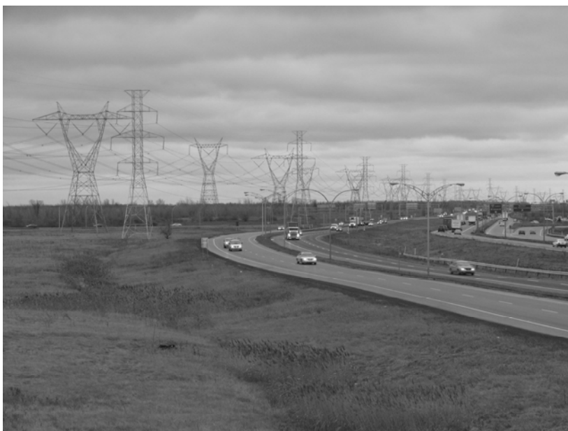
Figure 2 : L'expérience de conduite amplifiée à l'occasion la visibilité des lignes à haute tension (Source : CPEUM, 2004)
