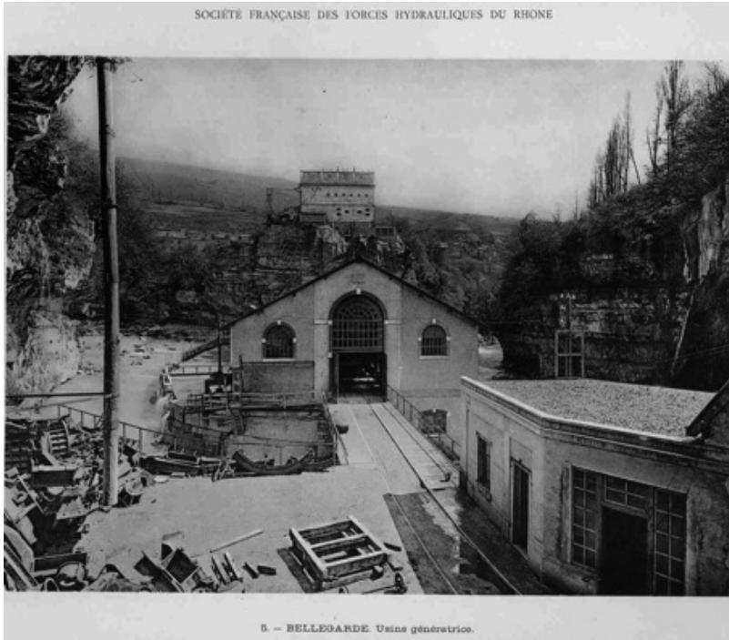
Figure 2 : Usine génératrice à Bellegarde-sur-Valserine en 1911 19
