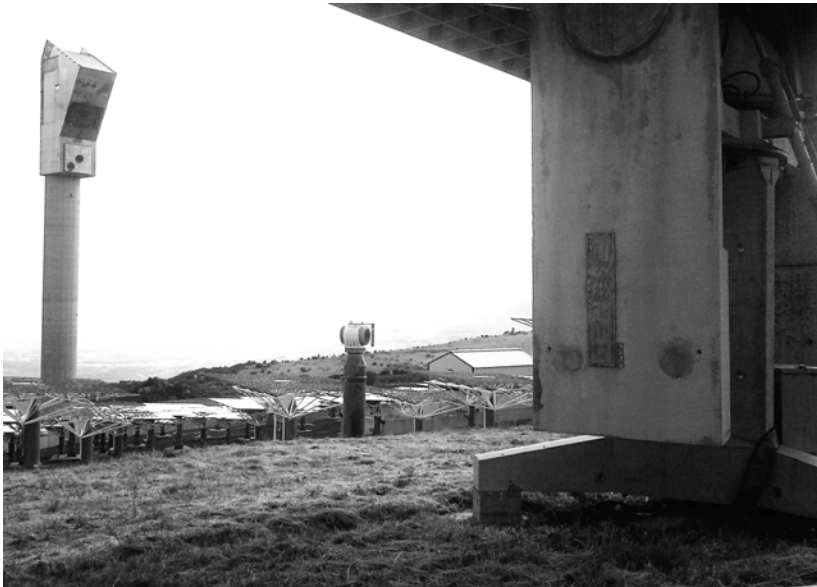
Figure 4 : Photographie de la tour de la centrale solaire Thémis, depuis le champ d'héliostats. © Cliché Sophie Pehlivanian
