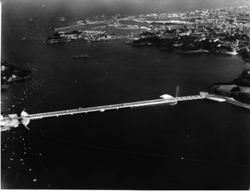
Figure 3 : Vue aérienne de la centrale marémotrice de la Rance, 1977, EDF/Michel Brigaud 20
