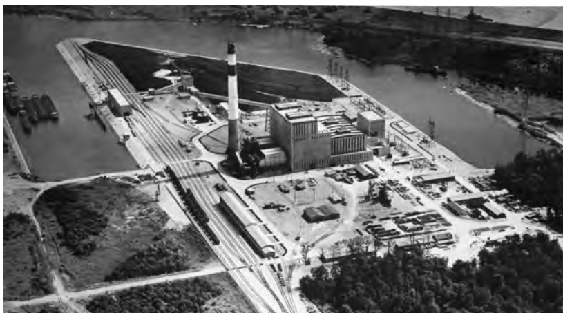
Figure 2 : vue aérienne de la centrale thermique de Strasbourg, publiée par EDF dans Travaux d'investissement , 1959.
