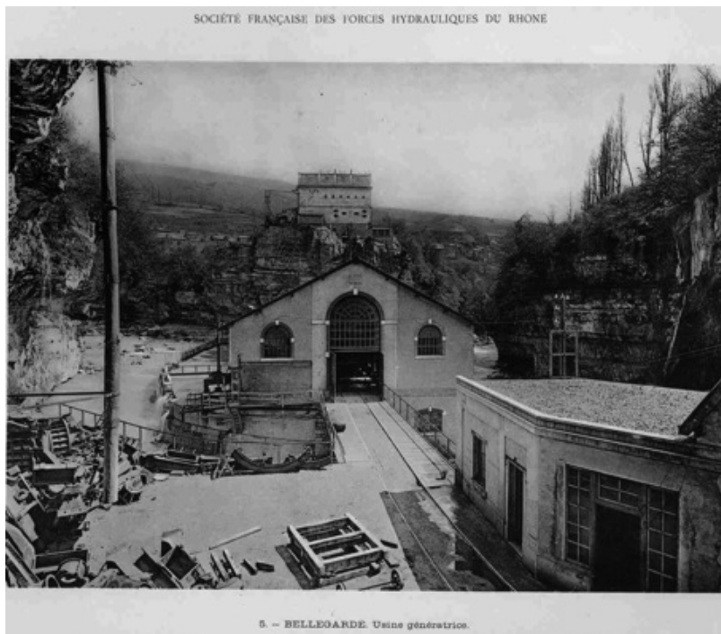
Figure 2 : Usine génératrice à Bellegarde-sur-Valserine en 1911 19
