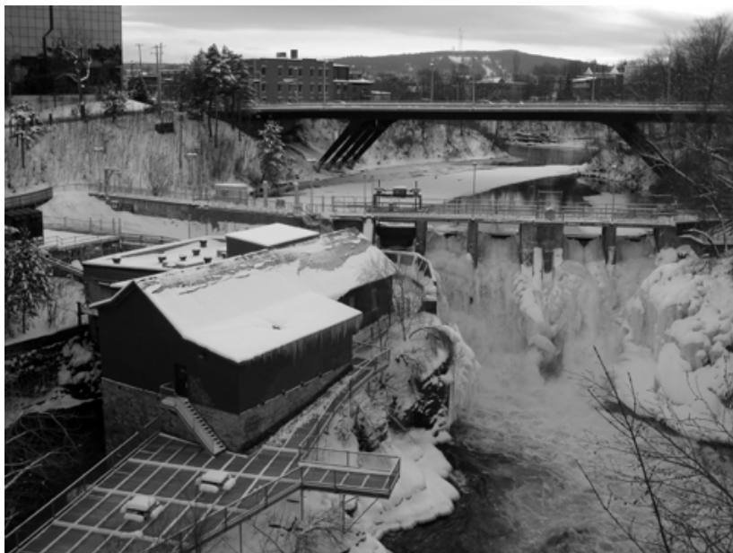
Figure 3 : vue sur la centrale Frontenac dans les gorges de la rivière Magog
