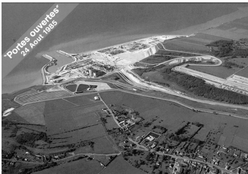
Figure 1 : Vue aérienne de la centrale nucléaire de Penly en construction. Carte postale imprimée et diffusée par EDF à l'occasion de visites du chantier en 1985. © EDF-REC/D. Poidvin
