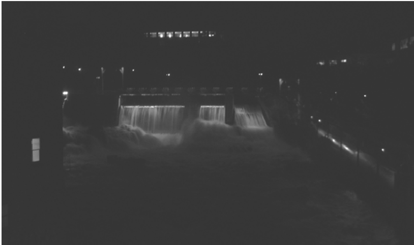
Figure 5 : vue sur le barrage Abénaquis illuminé
