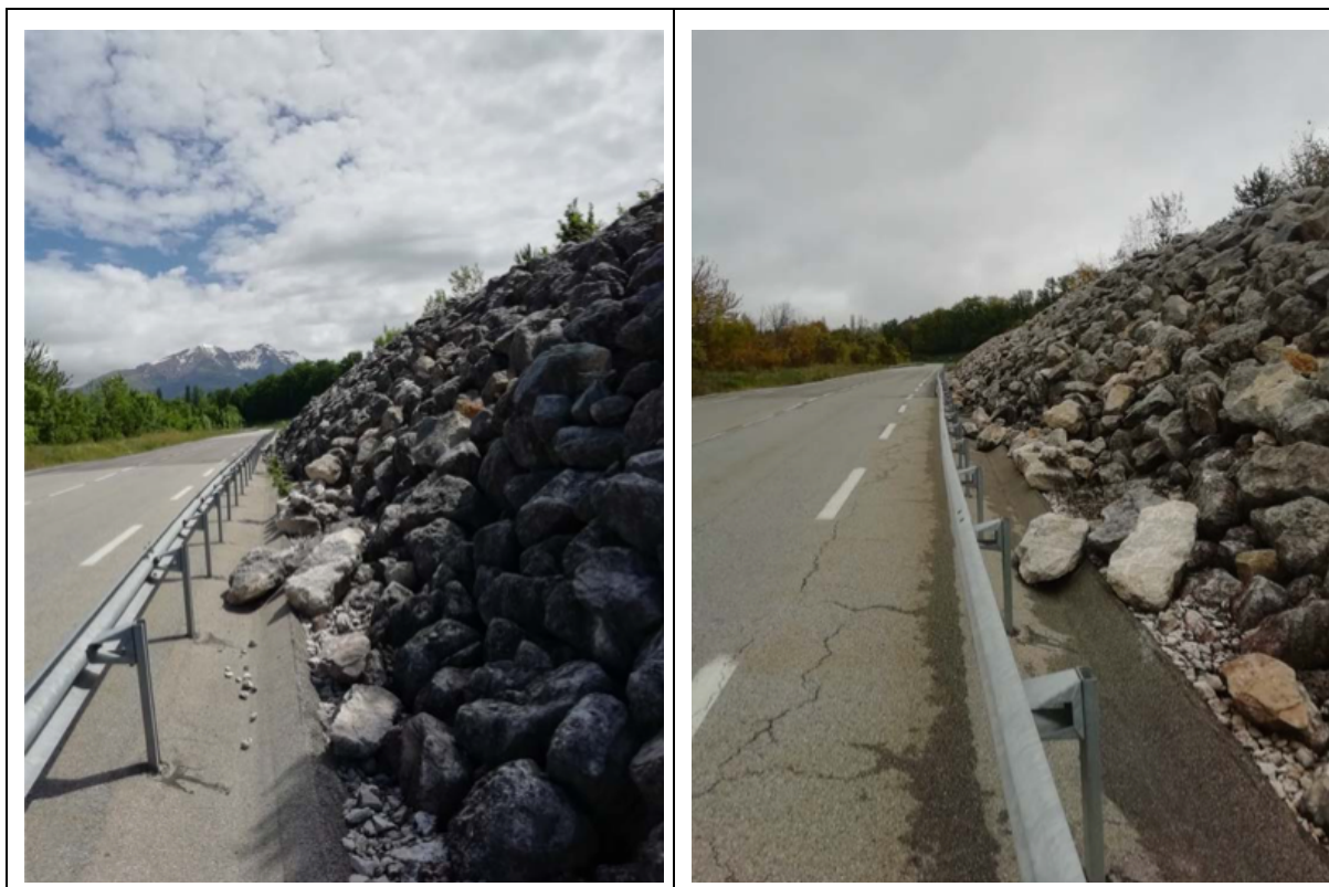
Photos 6 et 7 : Le confortement de Charlaix en juin 2021 et novembre 2022 (source : UGA)
