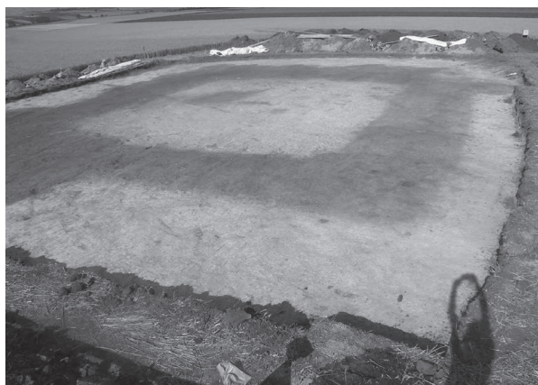
Fig. 2 : Vue après le décapage (ARGIS, 2002).
